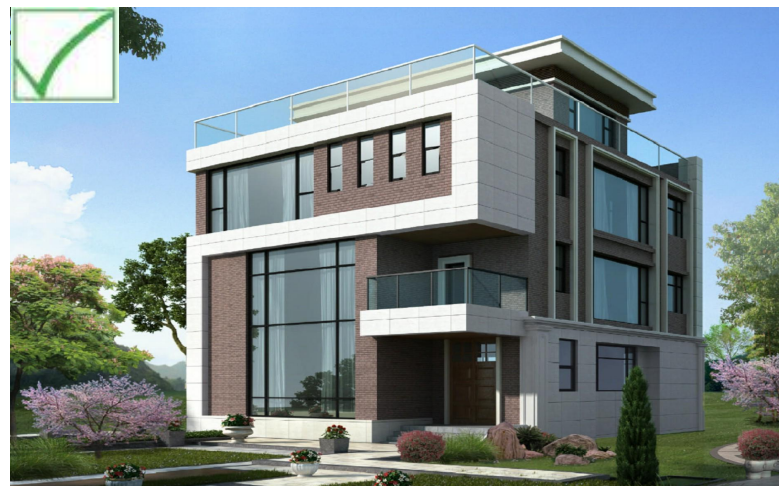
采取现代建筑风格，属于正面做法
