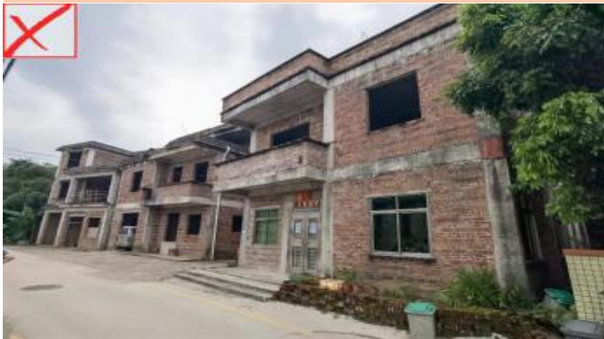
建筑外墙未进行装饰（赤膊房），属于负面做法
